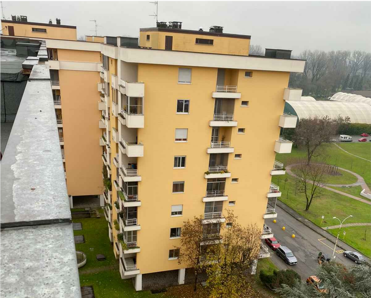
Foto prospetto lato ovest
