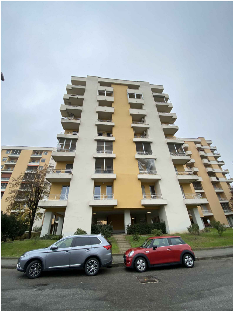
Foto prospetto lato sud
