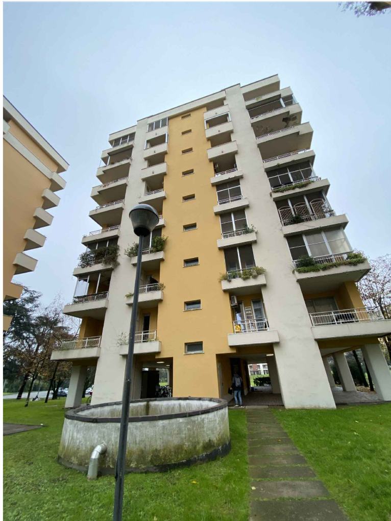
Foto prospetto lato nord
